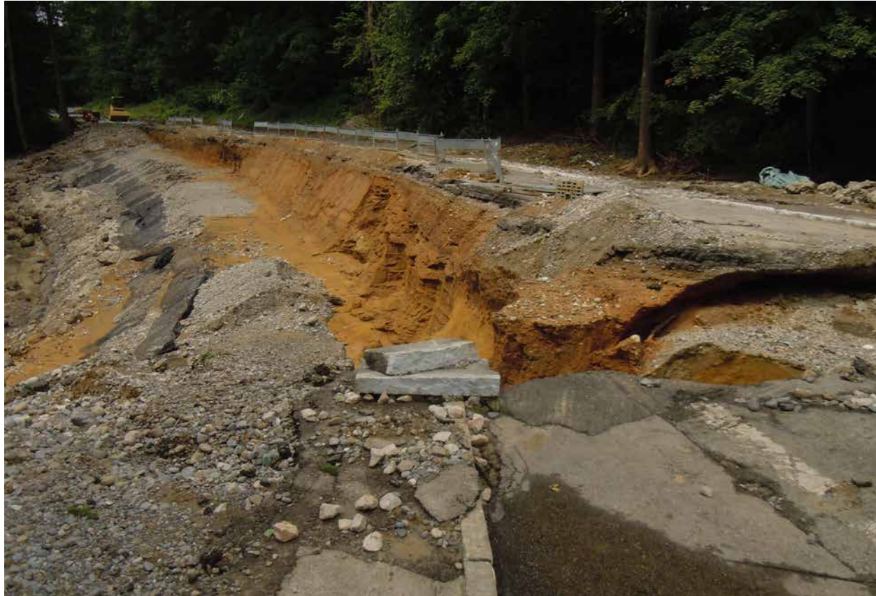
Zerstörte B 312 im Waldmannsgraben unterhalb Winterreute nach dem Starkregen vom 24. Juni 2016
